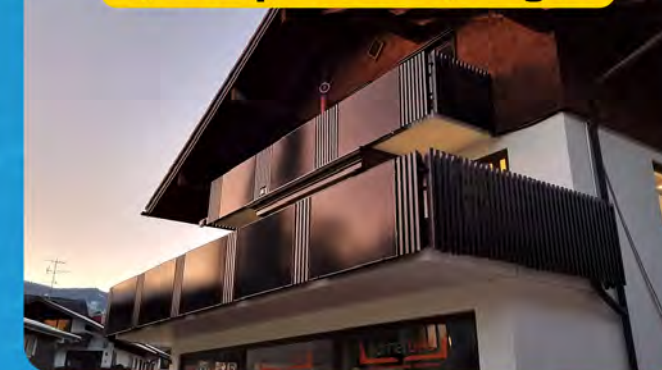
8,1 kWp Fischen, Allgäu
