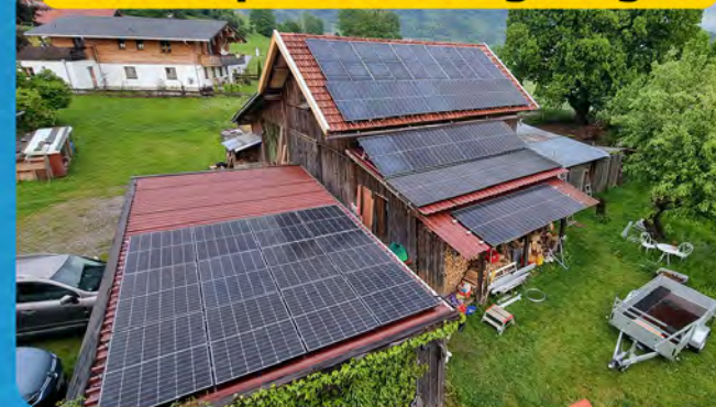
23,4 kWp Rettenberg, Allgäu
